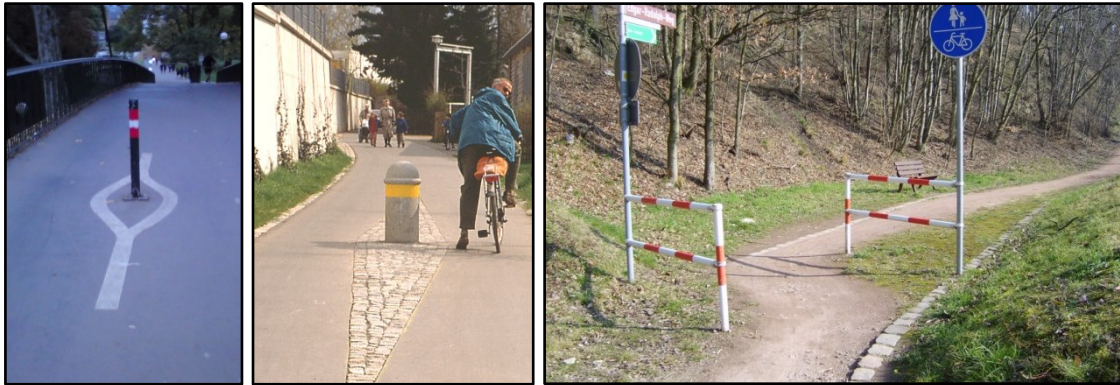
Abb. 78 Beispiele zur Verbesserung der Verkehrssicherheit an Pollern / Umlaufsperrn
