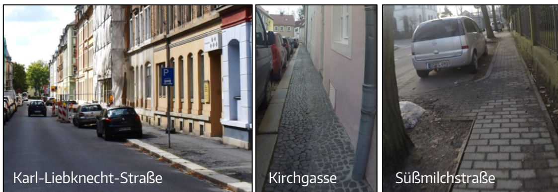
Abb. 39 nicht ausreichend breite Gehweganlagen
