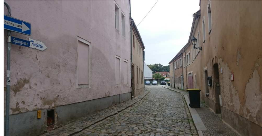
Foto 20: Städtebaulich triste Nebengasse der Bahnhofstraße / starker städtebaulicher Kontrast zum sanierten Altmarkt
